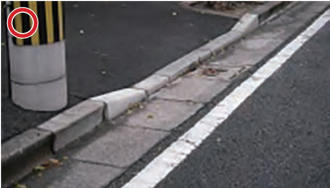
歩道切り下げ工事施工後
