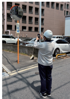
▲スマホを使ってカーブミラーを撮影し、診断をしている様子
