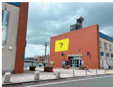
▲壁面アート設置場所(海峡プラザ東館)
